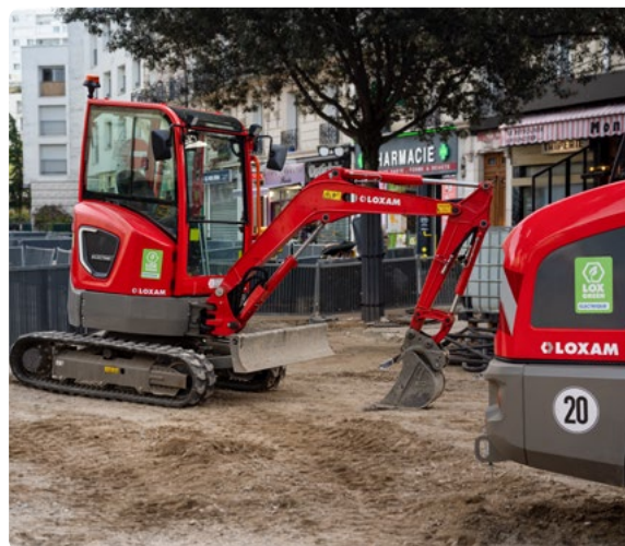
Exemple de chantier bas-carbone
