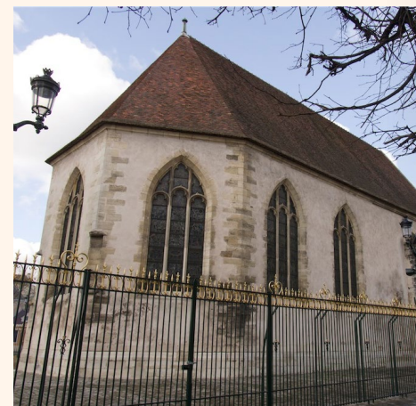
Église de Puteaux - © Fondation du patrimoine
