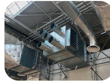
Installation des structures de transmission et récupération de l'air froid
